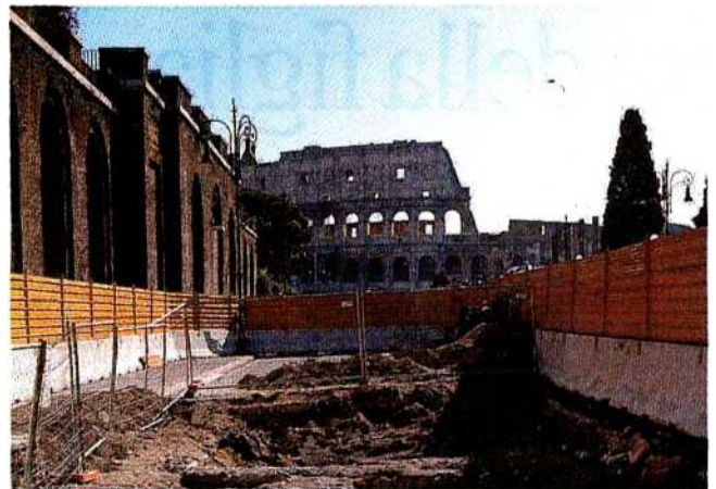
Il cantiere della metropolitana al Colosseo
