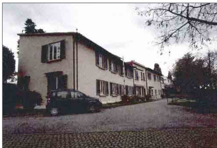
2) Veduta della parte più recente del complesso, che può essere demolita e ricostruita
