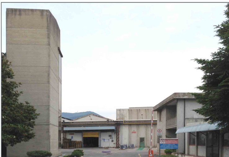
1) Veduta dell'ingresso carrabile all'area da via delle Due Case
