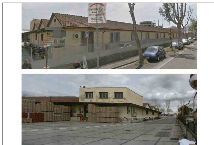
2) Altre immagini degli edifici esistenti da demolire
