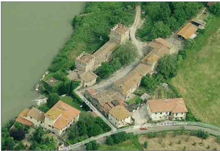
1) Vista del complesso
