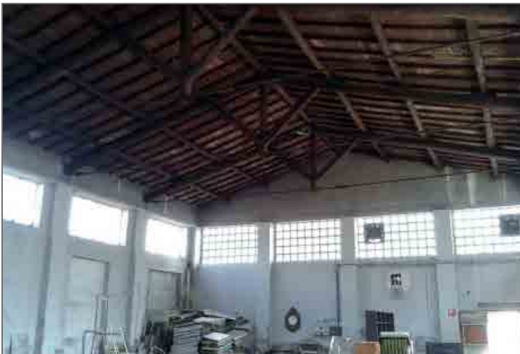
3) Veduta interna di uno degli edifici dismessi, con copertura in legno
