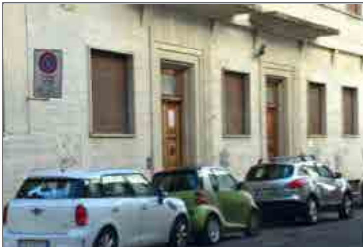
1) Vista dell'ingresso dell'edificio
