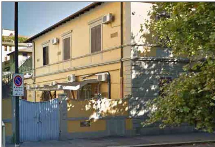
1) L'ingresso carrabile sul Viale Mazzini
