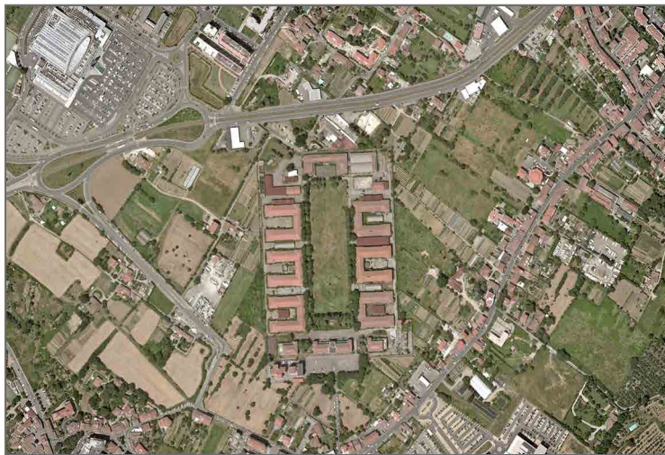
Vista attuale del complesso.
