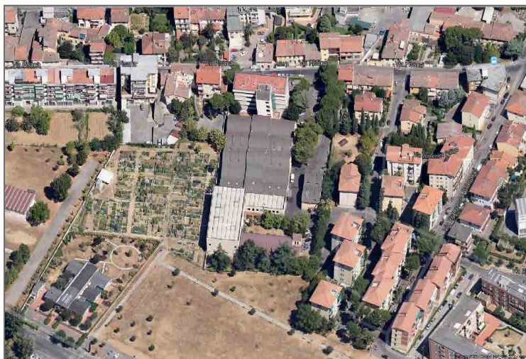
1) Vista dall'alto del complesso industriale da demolire; in basso, il verde pubblico adiacente
