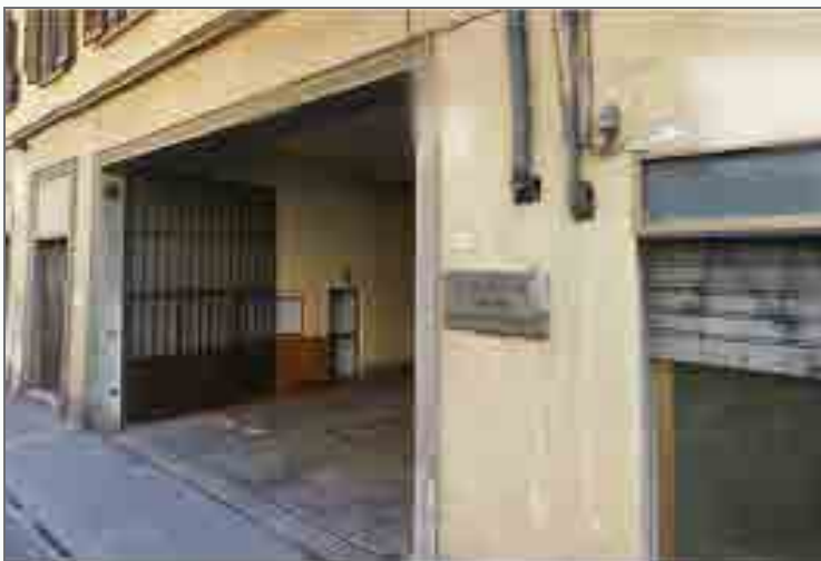
3) Varco d'ingresso su via Romana
