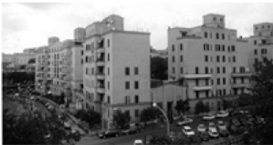
Il complesso di Val Melaina
