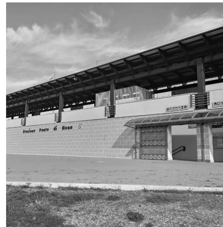
La Stazione di Ponte di Nona sulla linea FL2
