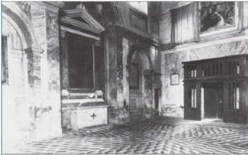
Sant'Urbano dei Pantani prima della demolizione
