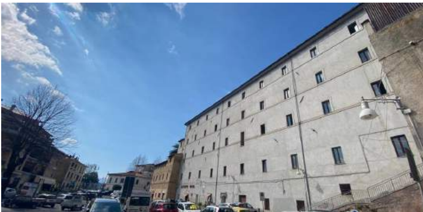
Intervento n. 52 – Ristrutturazione e manutenzione straordinaria Palazzo Braschi a Subiaco
