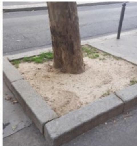
Eliminazione dell'ostruzione della formella e/o dell'impedimento della crescita dell'albero prevalentemente a causa di strutture preesistenti (es., griglie, cordoli ecc.) e/o costituzione dei nuovi cigli della formella di dimensioni adeguate allo sviluppo dell'albero.
