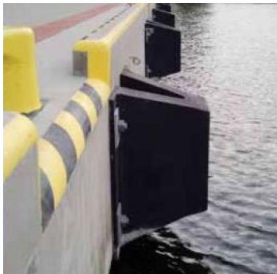
Figura 3.20: tipo di parabordo
