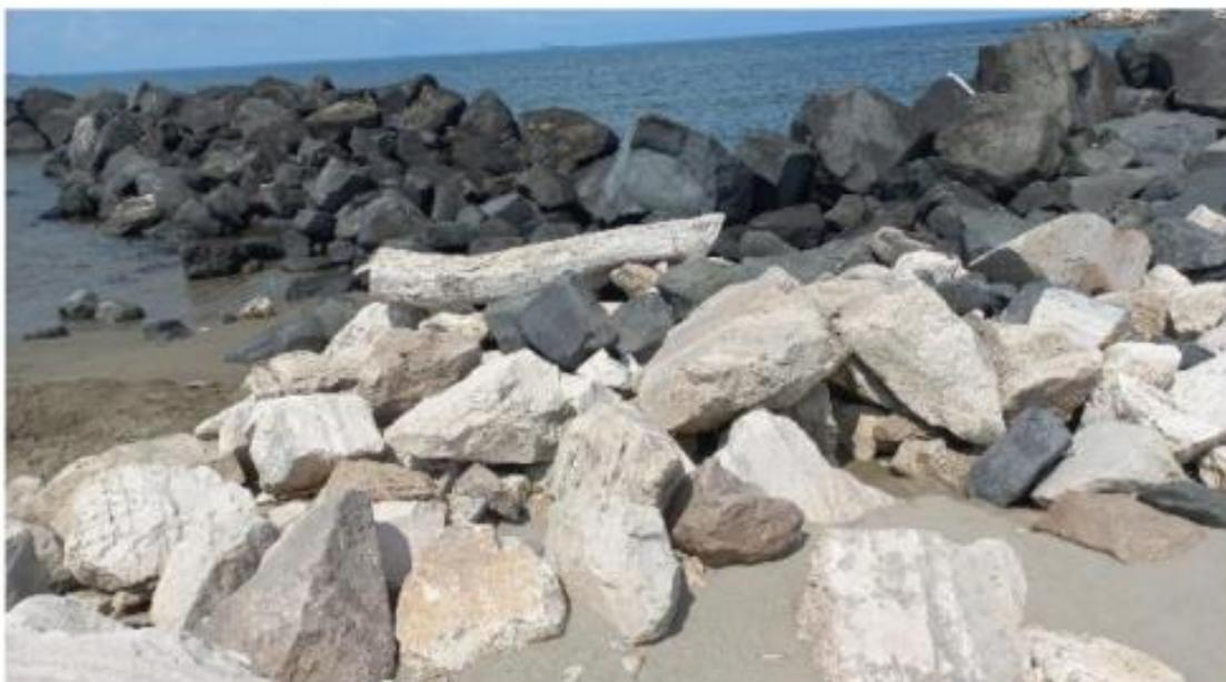
**Figura 4.9: Blocchi costituenti le barriere di protezione antierosione**
