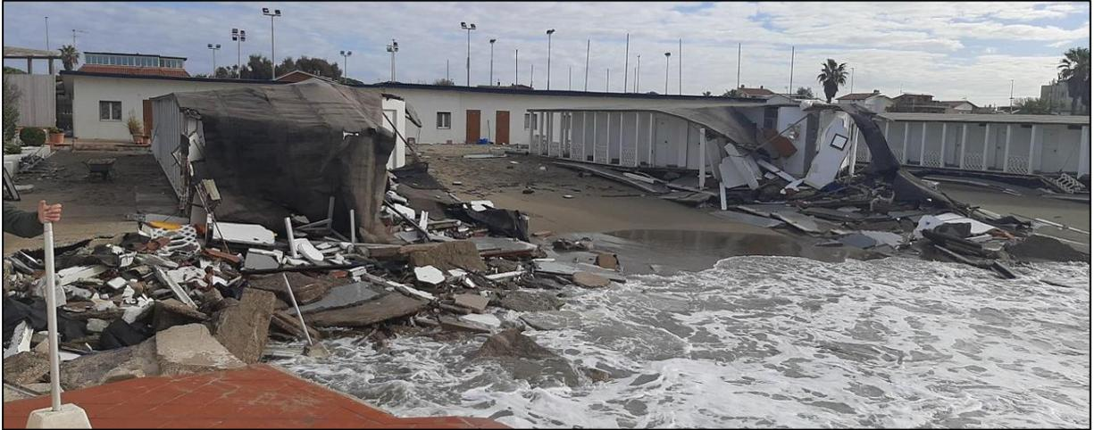
**Figura 8.3: Crollo delle cabine de La Nave a seguito delle mareggiate dell'inverno 2022; foto n. 2.**
